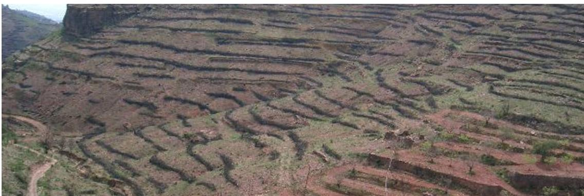
Figura 2.9. Estructuras (fajinas) perpendiculares a los flujos de agua para frenar la escorrentía en laderas con suelos deleznales y fuerte pendiente. Incendio de Calderona (2004).
