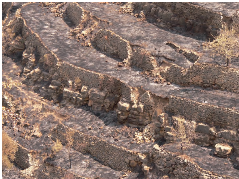
Figura III-10. Punto de muestreo con bancales abundantes, colonizados (antes del incendio) por vegetación forestal y con desmoronamientos generalizados.
